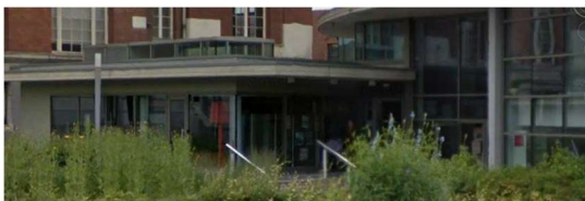
MAISON DES SERVICES (Hall d'Accueil de la Billetterie)
